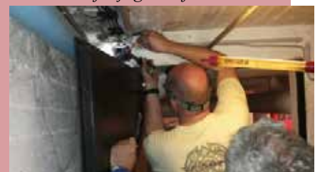
Erneuerung der Elektroinstallation
