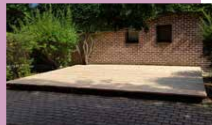
Bühne nach der Sanierung
